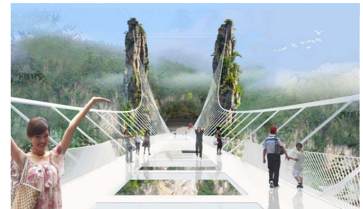
世界最大のガラス床吊り橋（中国） (L 430 m x W 6 m x H 300 m)
